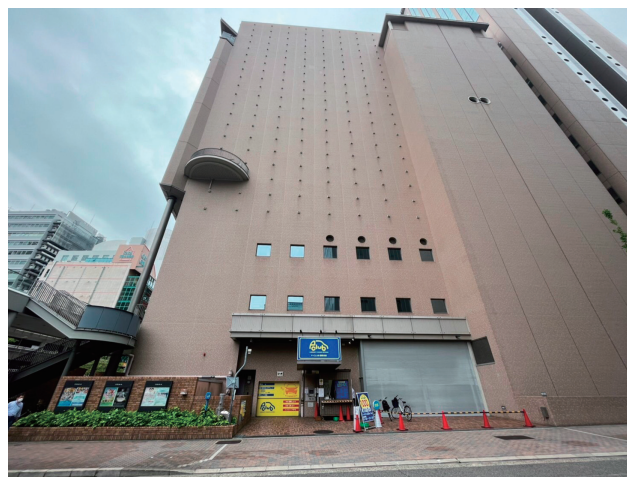
P-CLUB 国際会館の立体駐車場
